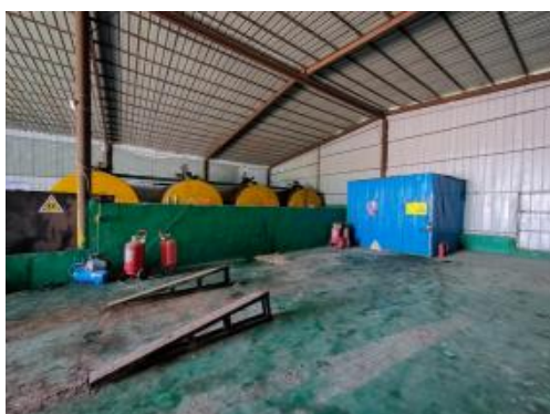
厂房内部东侧废矿物油暂存区现状
