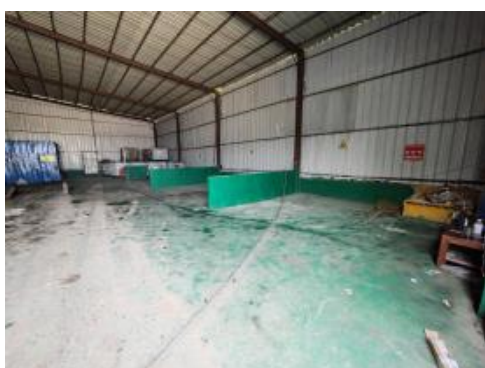
厂房内部西侧空置区现状
