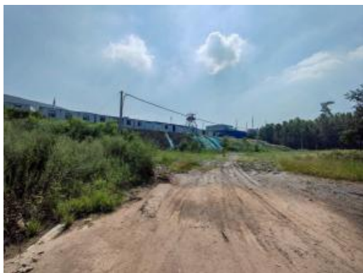
厂区东侧现状
