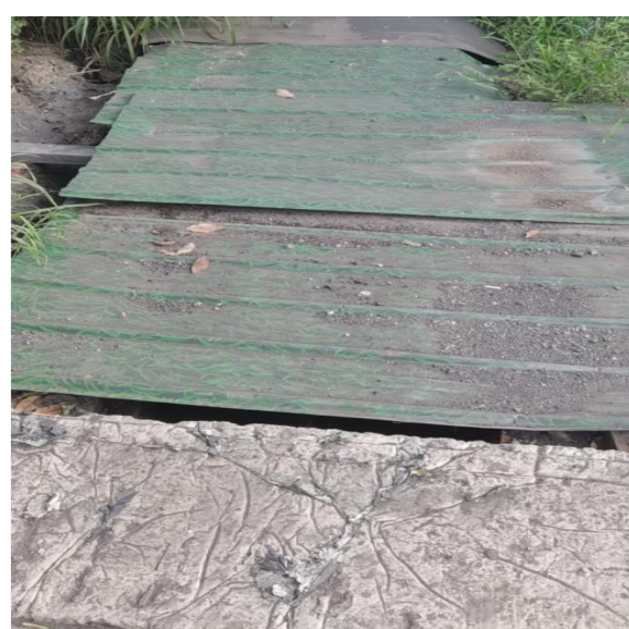
厂区现有洗车废水沉淀池
