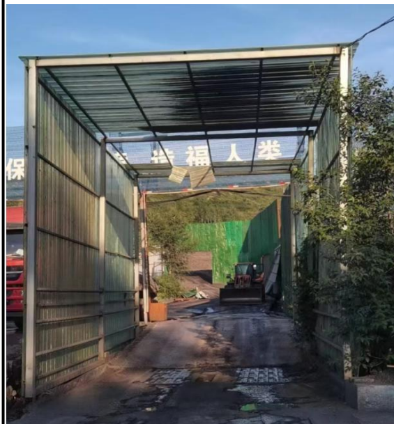
厂区现有洗车设施
