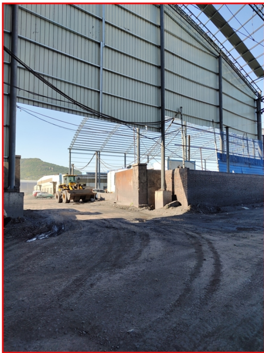
北侧的平顶山市华宇平安新型建材有限公司已废弃砖厂
