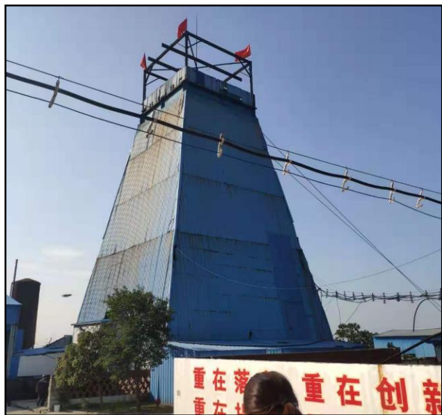
进风井（将改造成回风井）
