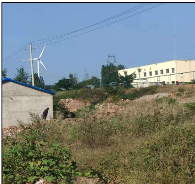
北二工业场地东侧 35kv 变电站
