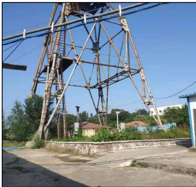
回风井（将改造成进风井）
