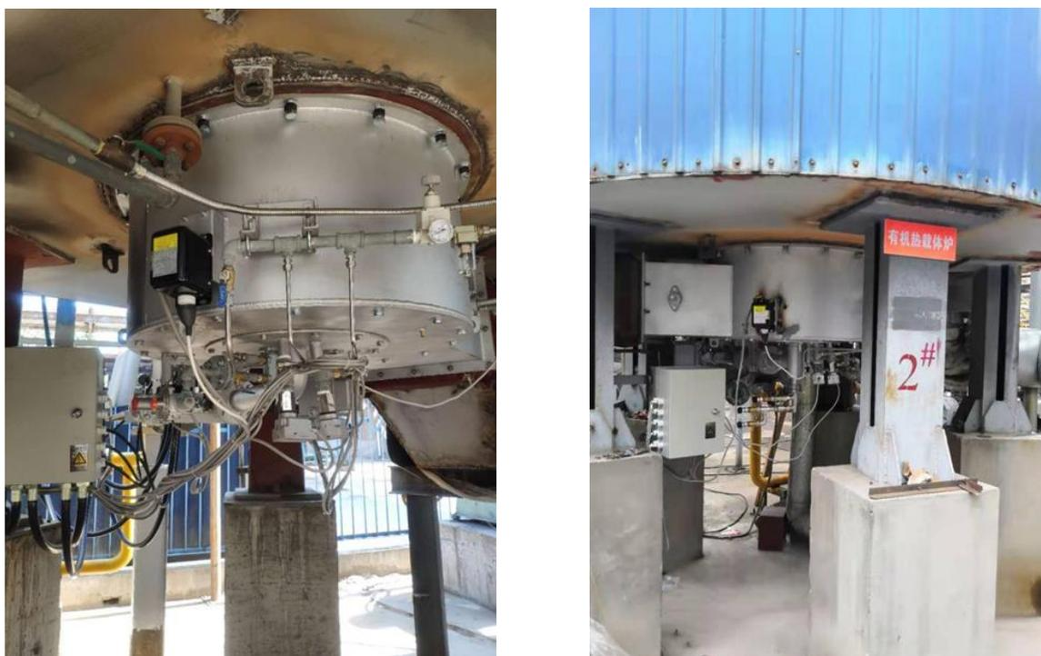
图 3-11 燃气锅炉低氮燃烧器改造完工
